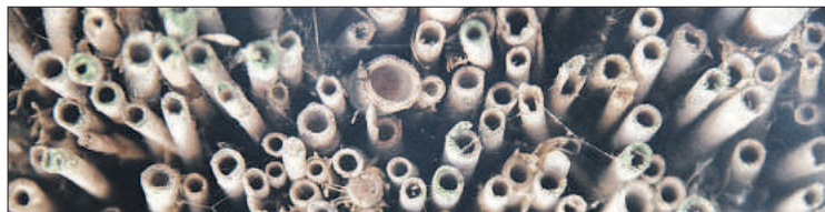
Naturprodukt auf dem Dach: Seit hunderten von Jahren wird Reet zum Decken von Häusern verwendet. In jüngerer Zeit kommt es zum vorzeitigen Verrotten von Dächern nach manchmal nur fünf Jahren. Foto: at
